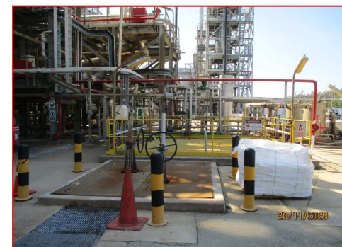
(24) บ่อรวบรวมน้ำเสียจากพื้นที่กระบวนการผลิต
