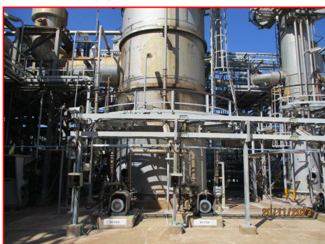
(5) ปั๊มสุบจ่าย NaOH บริเวณ Off Gas Scrubber
