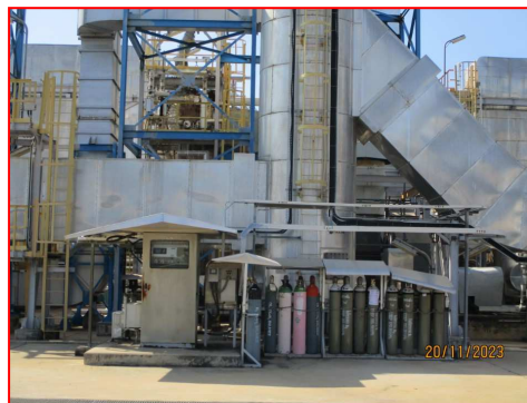
(12) ระบบ CEMs บริเวณ Boiler Stack Vent Gas
