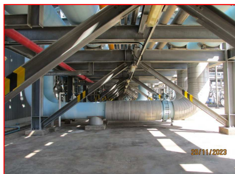
(14) ติดวัสดุลดเสียงจากท่อน้ำ
