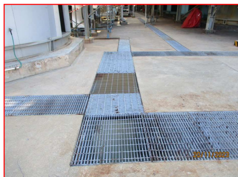
(23) รางรวบรวมน้ำเสียจากพื้นที่กระบวนการผลิต
